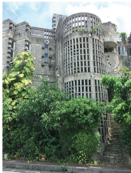
アトリエガイの事務所。半円形の外階段を上った3階
