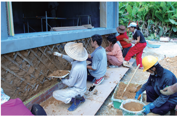
今年の8月26日に今帰仁村で開催した「土塗りワークショップ」。近隣のパイン畑から掘り起こした赤土で外壁を仕上げる体験をしました
